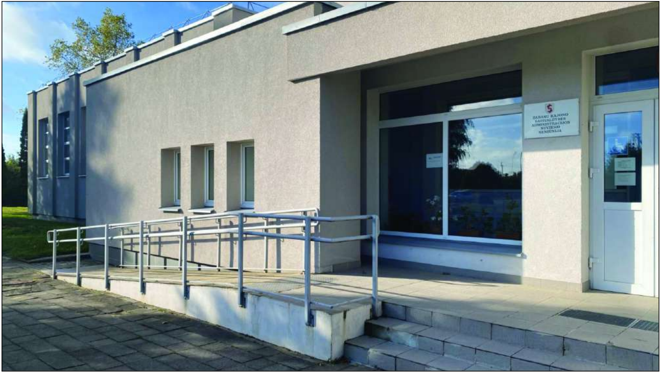
Rytinio fasado fotografacija. Pagrindinis įėjimas į pastatą
