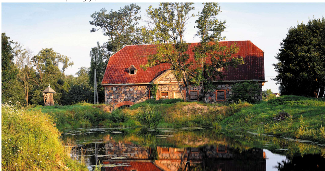
6 pav. Antalieptės vandens malūnas.
